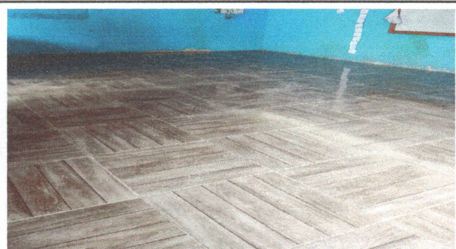
Foto 3: Colocacion de piso ceramico modulo 1
