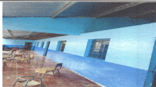
Foto 4: Colocacion de piso ceramico al corredor modulo 2
