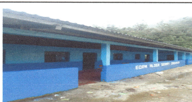
Foto 6: Aplicación de pintura modulo 2
