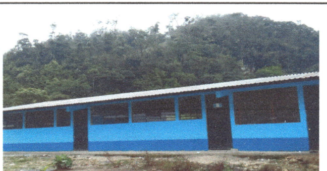
Foto 5: Aplicacion de pintura exterior modulo 1
