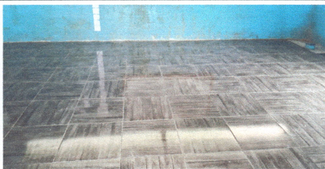
Foto1: Sustitucion de piso de torta por ceramico (Modulo 2)
