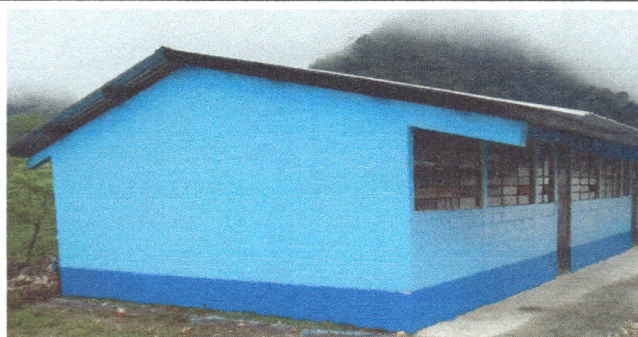
Foto 2: Aplicación de Pintura exterior Modulo 1
